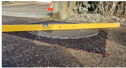
Schacht am Wildemerweg
