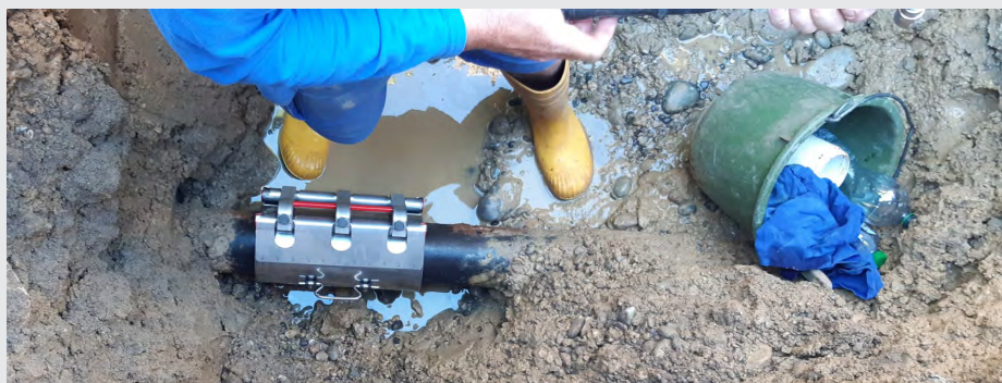
Geflickte Wasserleitung nach einem Leitungsbruch am Haslenweg (August 2022).
