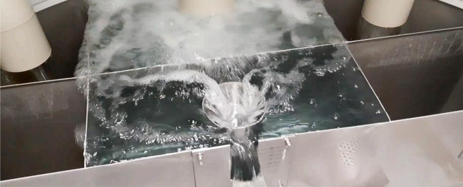
Die Brunnstube der Kreuzackerquelle am **1. Februar 2021**. Zwei der drei Einläufe gehen direkt in den Überlauf, die dritte (mittlere) schüttet mehr als 500 Liter pro Minute (das ganz Dorf braucht z.B. an einem Montagabend ca. 80–100 L/Min).
